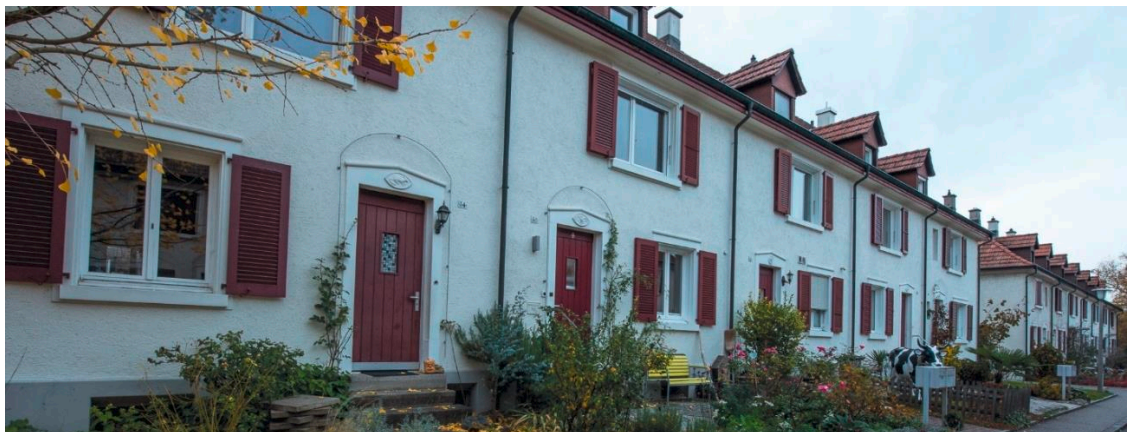
Abbildung 5, Foto Siedlung Wasserhaus
