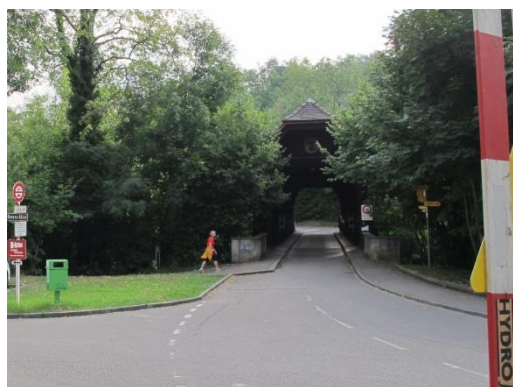
Abbildung 9: Brücke über die Birs
