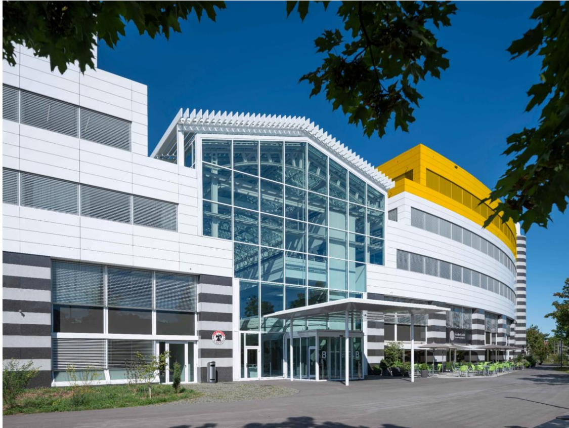
Haus C – bestehender Eingang zum Spenglerpark. Die Gebäudestruktur ermöglicht eine klare und repräsentative Adressbildung.
