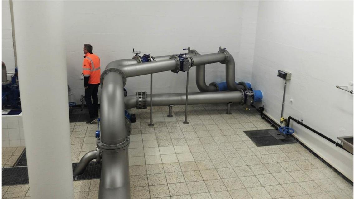
Abbildung 12 Bestehende Überlaufleitung mit Siphon
