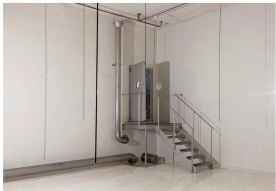
Abbildung 11 Edelstahlleitung im Rohrkeller
