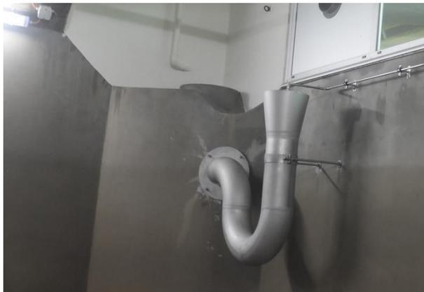
Abbildung 13 Neu beschichtete Entleerungsleitung
